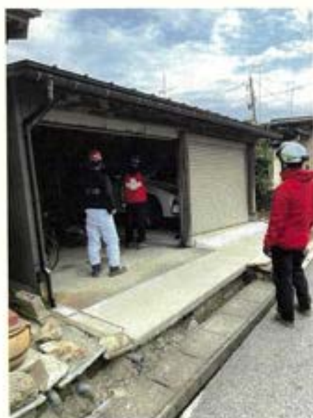
・2月15日 シャッターが上がらない車庫から車を救出
