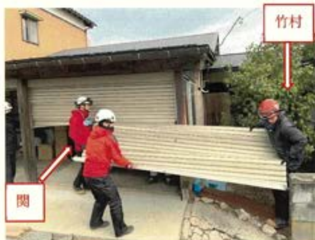
火災時の進入要領を活用し、シャッターを取り外す。
