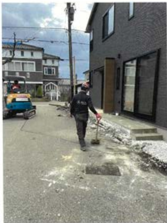
・2月15日 ブロック塀撤去
