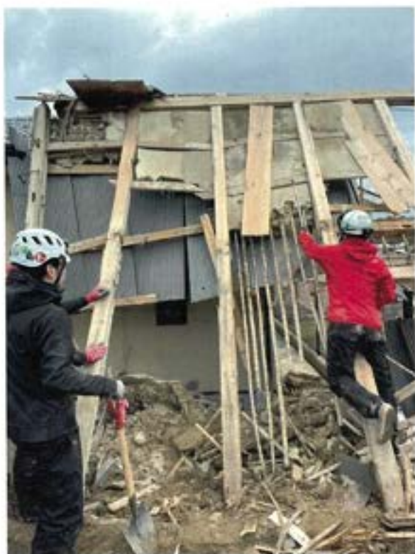
・2月15日 隣家に倒れた壁を撤去
