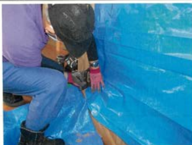
室内養生 ブルーシート張り
